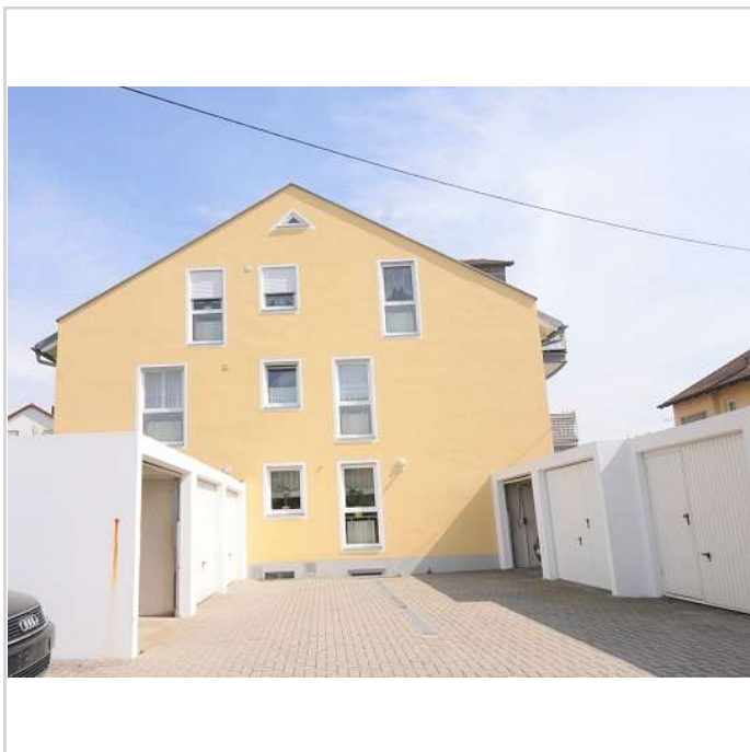
Haus mit Garagen
